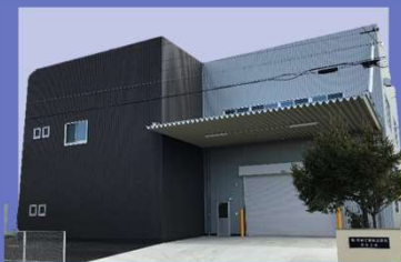
第五工場建屋 全景
