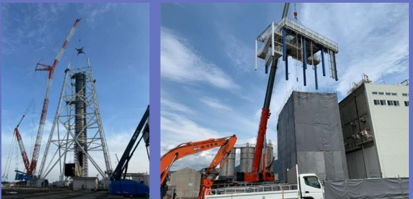
左： 200m煙突撤去工事 右： 構造物撤去解体工事
