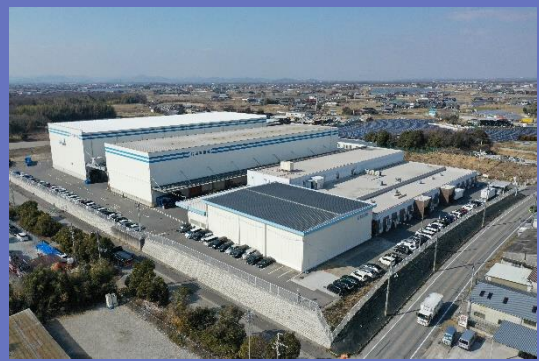
神戸ロジスティクスセンター
