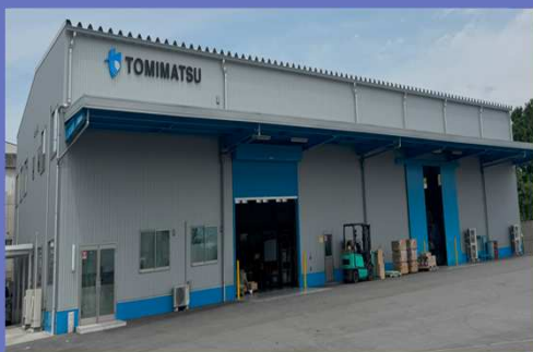
富松工業 本社工場
