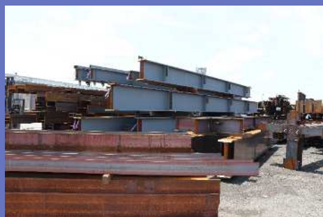
主力製品（重量鉄骨の加工）
