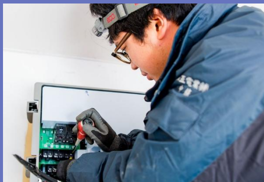
主力事業 電気設備工事
