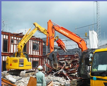
解体工事の現場
