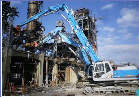
当社が行う解体工事の様子
