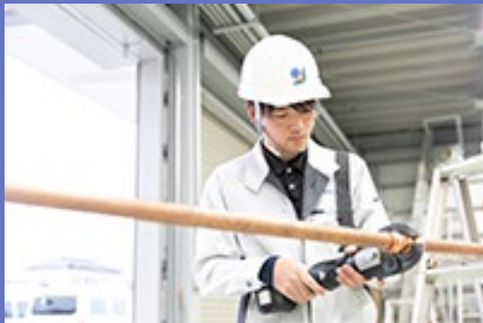
主力事業 冷凍設備施工風景
