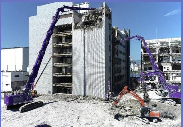
大型解体専用重機を用いて高層ビルなどの建築物の解体工事を専門とする
