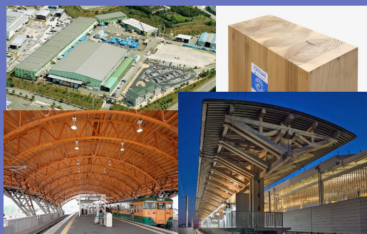
左上：当社本社工場（奈良県五條市） 右上：構造用集成材（当社製品） 左下：JR二条駅（当社製品の施工事例） 右下：JR熊本駅（当社製品の施工事例）
