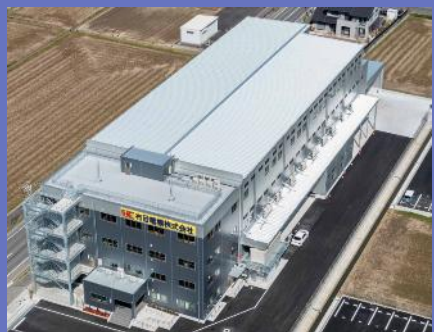
愛西工場(愛知県愛西市) トランスユニット、BOX・電源盤／制御盤 生産拠点(UL508A認定工場)
