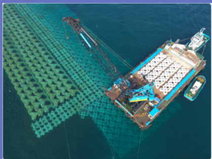
当社所有船「第三大伸」 （作業船によるブロック据付工事）
