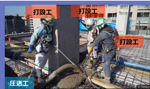
コンクリート打設
