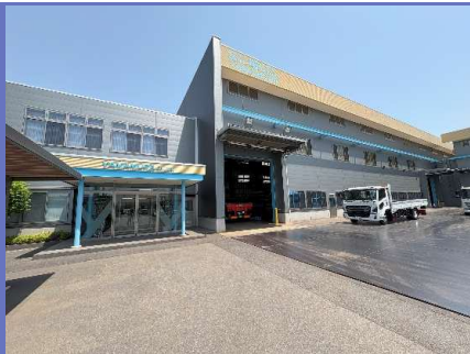
群馬支店 第一工場 外観
