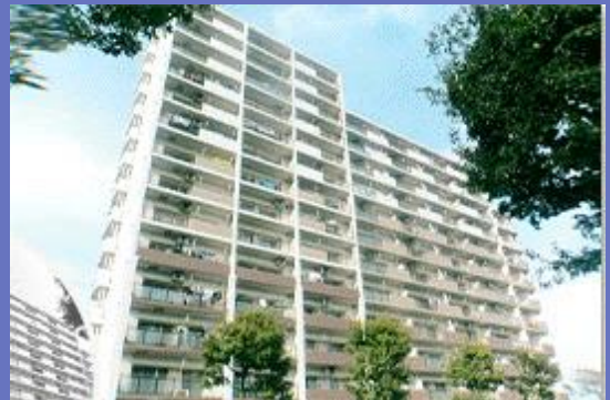
大規模修繕工事対象のマンション
