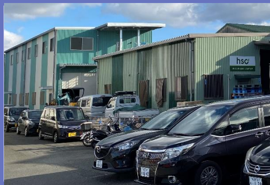
自社所有 本社事務所と物流倉庫
