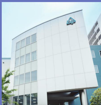
不二製作所本社 (外壁はブラスト加工されたものです)
