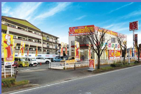
フラット7 福岡志免店外観
