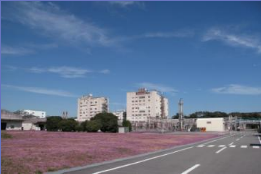
磯原工場内（今回新棟建設予定場所）
