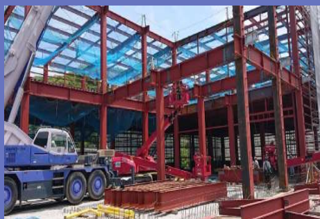
主力事業 鉄骨建方施工
