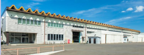
古川工業(株) 製造工場
