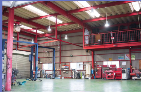
本社整備工場
