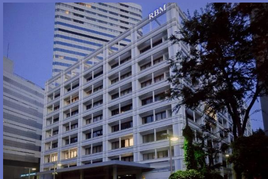
紀尾井町パークビル耐震補強工事
