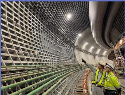
シールド工事中の大断面道路トンネル
