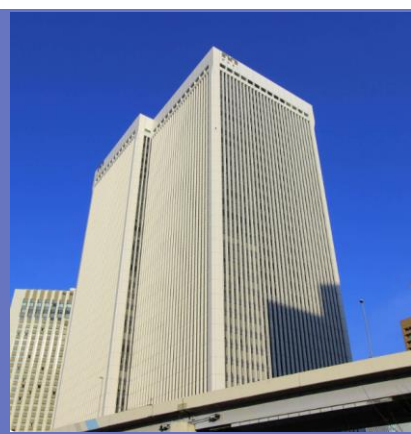
本社ビル外観
