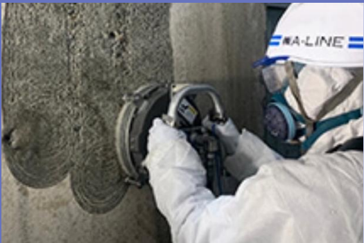
アスベスト工事（レベル1～3）
