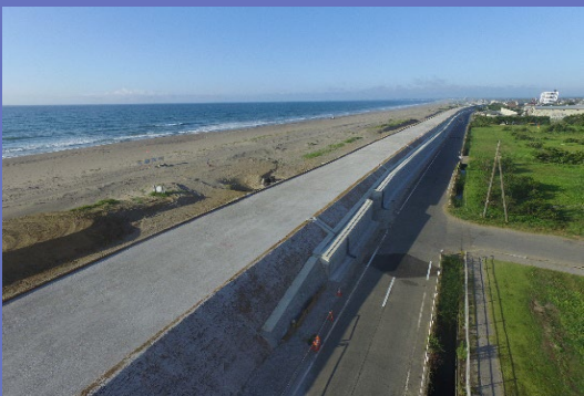
千葉県：九十九里海岸津波対策工事 （弊社施工）
