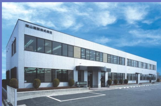
公共、民間施設の中大型建造物の建築工事を得意、施工管理アプリを自社開発
