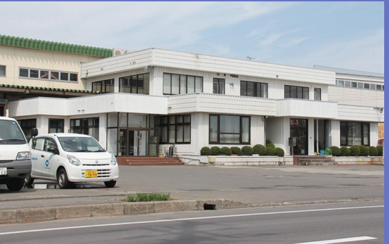
弘前本社事務所兼倉庫
