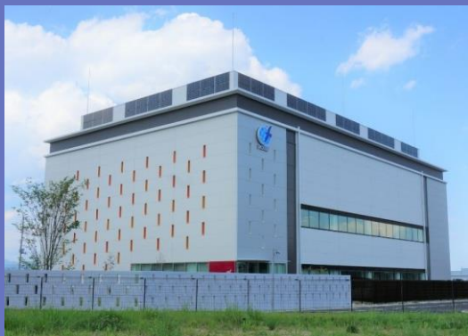
福島データセンター外観
