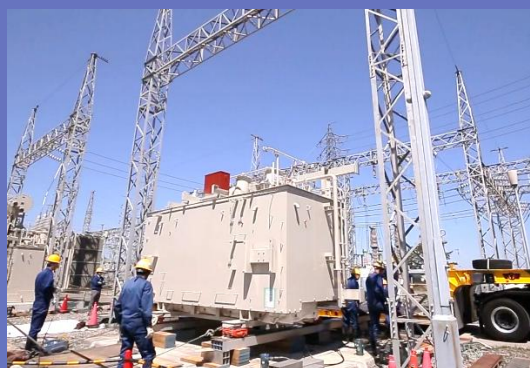
受変電設備の搬入・据付
