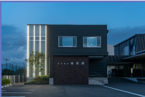
本社工場 / 設計開発棟
