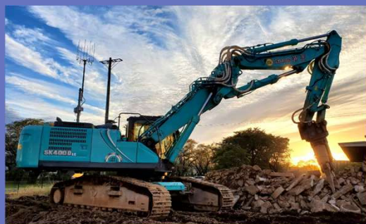
主力事業（大型建物解体工事）
