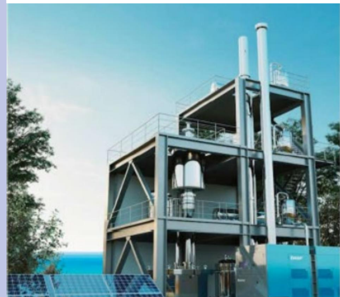
自社製油所(建設中)
