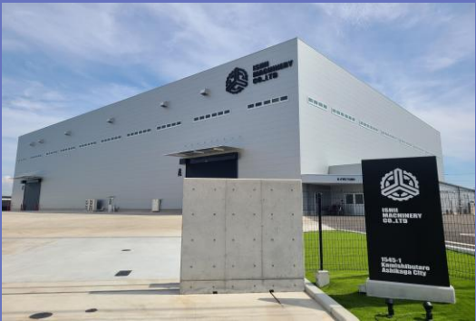
2025年7月竣工 新工場 『K-FACTORY』
