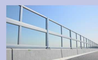
首都高速道路防音ガラス
