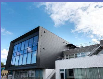
本社事務棟(2025年完成)
