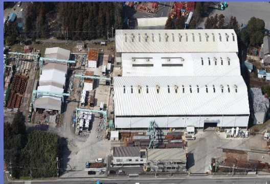
千葉工場 全景
