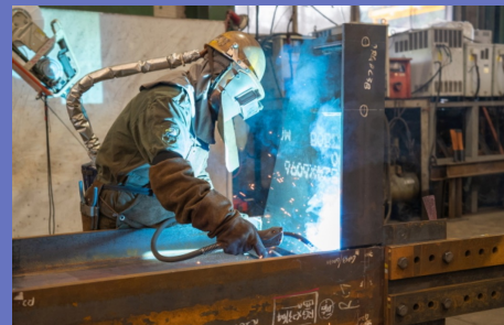
鉄骨の溶接作業の様子
