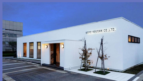
本社事務所 外観
