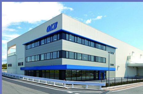
板金ソリューション・ファクトリー
