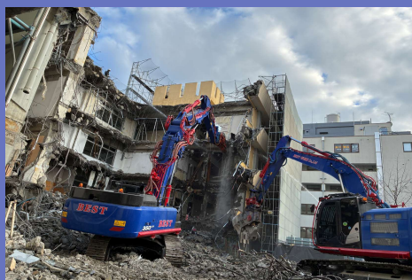
解体工事現場写真
