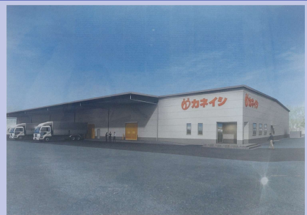
前橋南DC（建設中のセンター）
