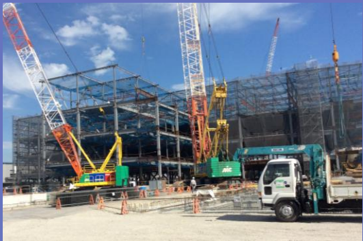
主力事業 鉄骨工事及び鉄骨製作
