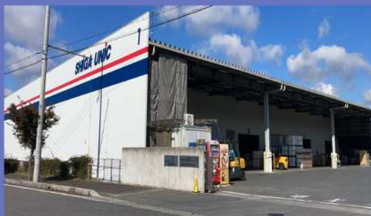
物流センター 天井クレーン倉庫
