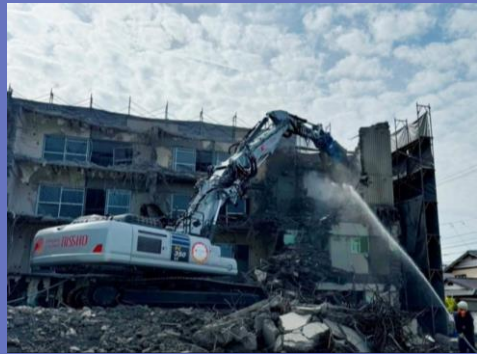
大型建物解体工事
