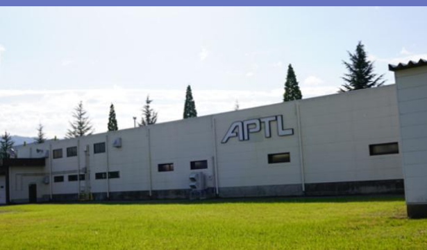
本社・第一工場
