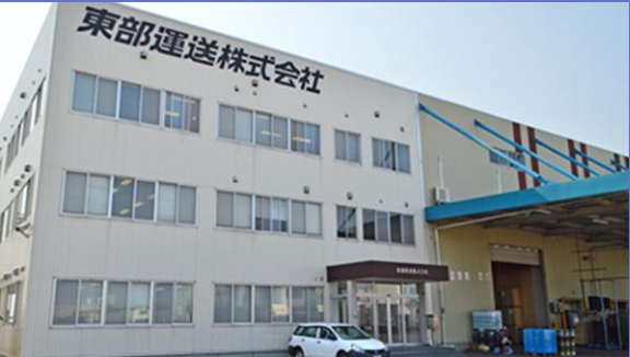
本社（社屋・倉庫）
