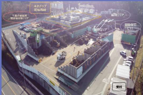
千葉市バイオマスチップ製造施設
